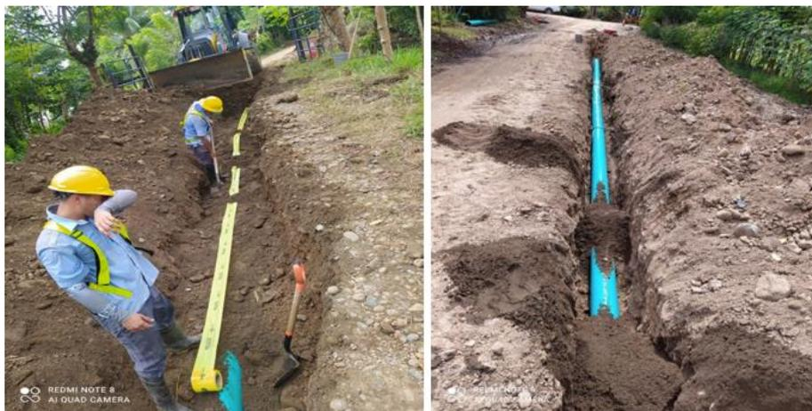
*Figura 54 Mejora de la red de distribución del sistema de agua potable de Ciudad Cortes, Osa.*
